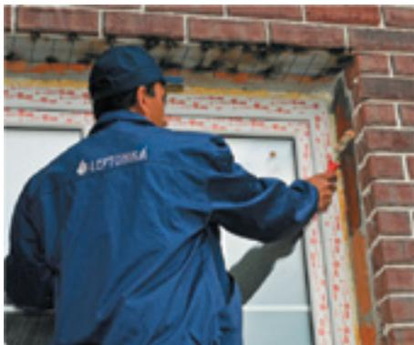
1. Очистите несущую поверхность от строительного раствора, высолов, плесени, пыли и других загрязнений. Нанесите грунтовку для фасадных работ.
