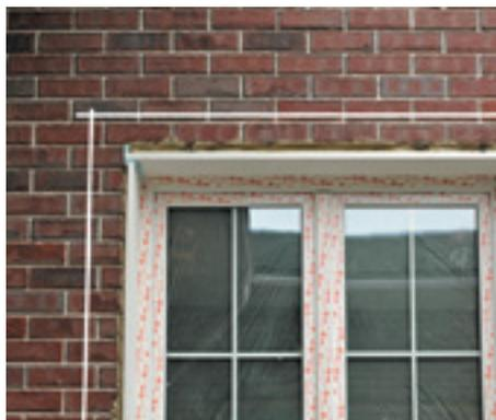
8. Произведите разметку стены для приклеивания наличников с помощью отбивочного малярного шнура.
