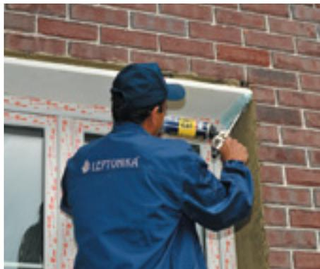
6. На место стыка элементов между собой нанесите клей-пену. Стыки элементов делаются с толщиной шва клея-пену 2-2,5 мм. При нанесении клея-пену учитывается время схватывания, указанное производителем на баллоне.
