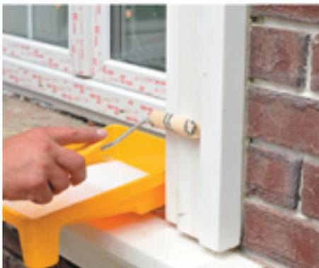
18. Смонтированные элементы необходимо обязательно прогрунтовать, используя грунт, рекомендуемый производителем для последующей декоративной отделки.
