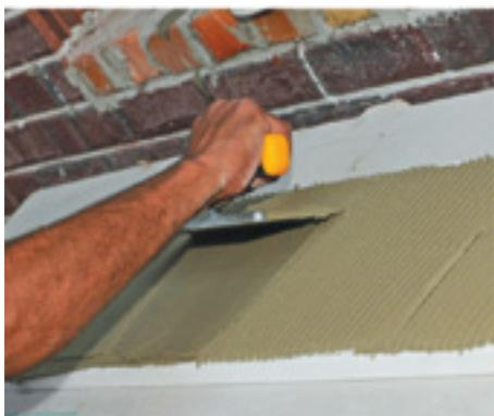
3. Подготовьте элемент откоса для монтажа. На места стыка элемента с несущей поверхностью нанесите клеевую строительную смесь. При нанесении смеси на элемент борозды от шпателя должны быть перпендикулярны бороздам на несущей поверхности.
