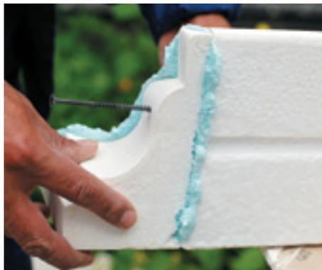
14. Зафиксируйте склеиваемые элементы только посредством аккуратно ввинченного шурупа.
