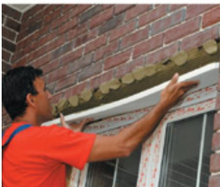
4. Элемент с клеевой массой вручную прижимается к несущей поверхности. Прижим продолжается до тех пор, пока вся клеевая масса не будет иметь надежный контакт с несущей поверхностью.
