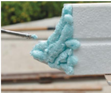
13. Валик клей-пены диаметром 15 мм должен быть нанесен на всю поверхность стыка элемента. При нанесении не допускайте пустот.
