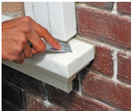
16. Покройте места подготовленных стыков декоративно-реставрационной смесью "DarMix" шпателем, плотно вдавливая смесь в шов.
