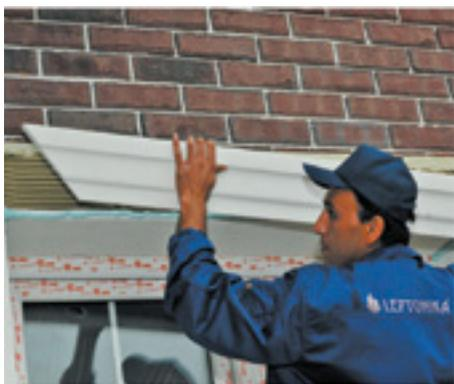
11. Заклейте малярной лентой место стыковки деталей между собой. На место стыка элемента с несущей поверхностью нанесите клеевую строительную смесь. После снятия малярной ленты, на место стыка деталей между собой нанесите клей-пену.
