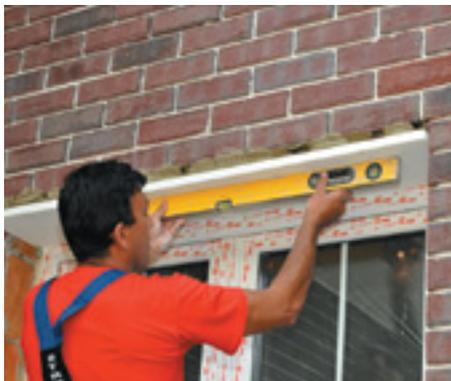
5. Проверьте с помощью измерительного уровня горизонтальность поверхности приклеенного элемента.
