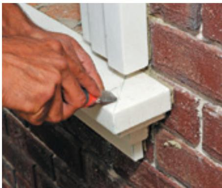
15. На смонтированных изделиях разделите все швы соединений, освободив 2 мм в ширину и глубину от верхнего края поверхности, для нанесения декоративно-реставрационной смеси "DarMix".
