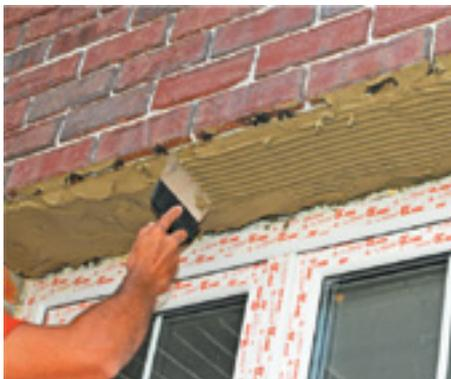
2. Нанесите на несущую поверхность здания подготовленную клеевую строительную смесь. При нанесении смеси борозды от шпателя на поверхности должны быть вдоль обрабатываемого участка.
